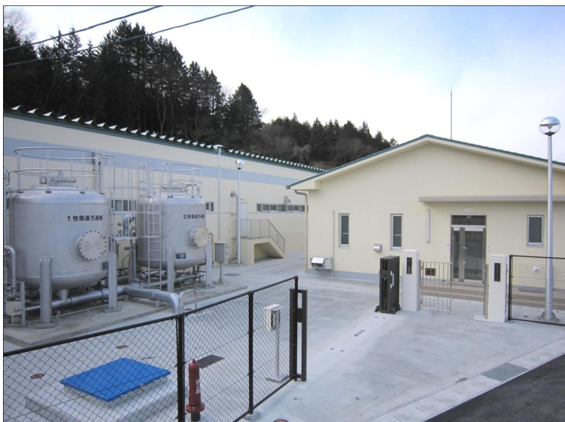
太田輪浄水場
