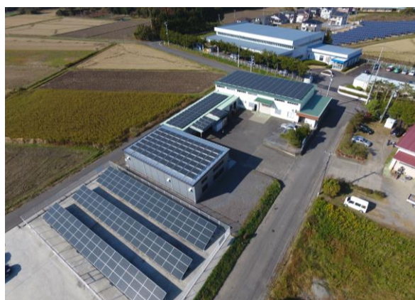
町内における太陽光発電設備の設置事例（町内事業者）
