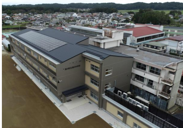
町内における太陽光発電設備の設置事例（浅川町立浅川中学校）
